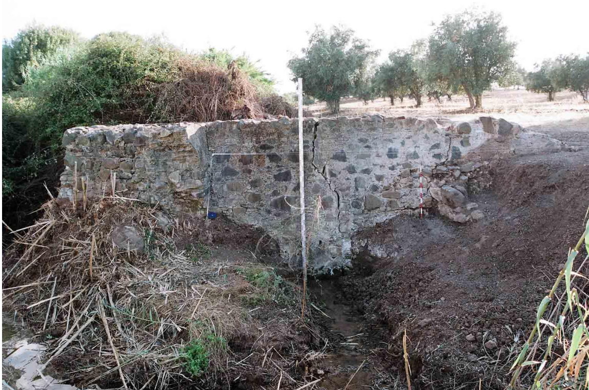
Figura 18 – Barragem com muro retilíneo, em opus incertum , com contraforte.
