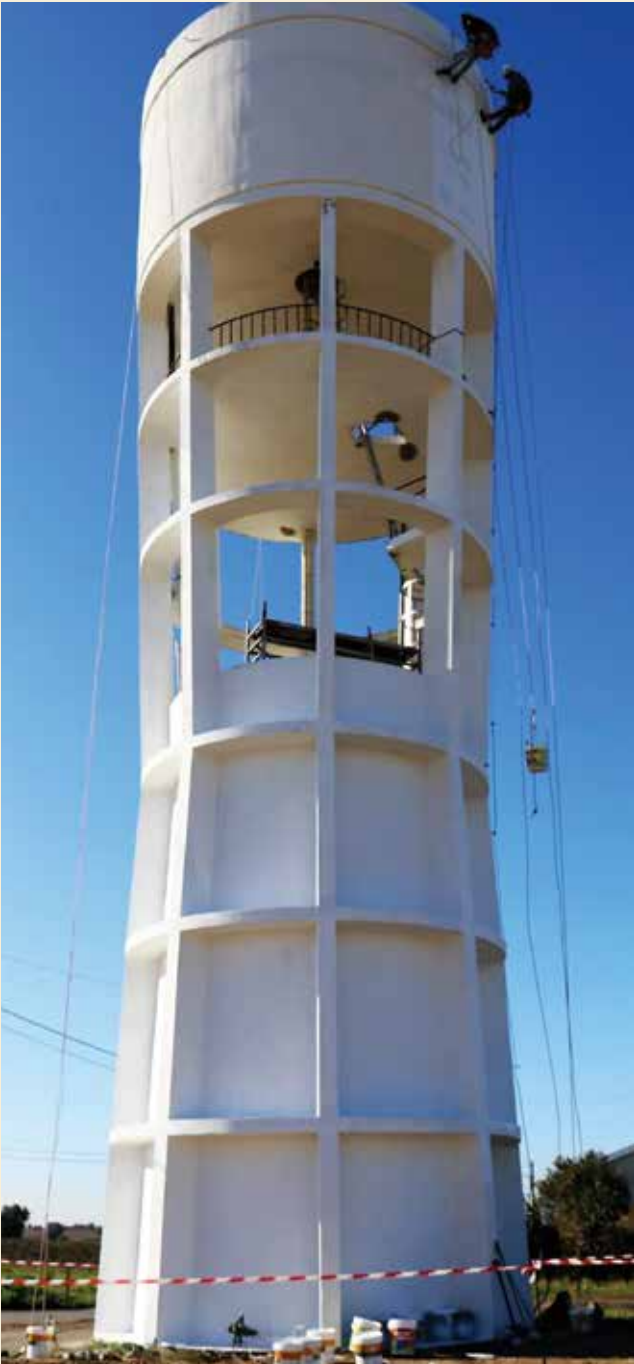
>> Impermeabilização, substituição de diversos equipamentos e agora a pintura do reservatório em Olhas
