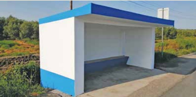
>> Os serviços da Câmara Municipal procederam à pintura do Abrigo de Passageiros no ramal de Peroguarda-Alfundão
