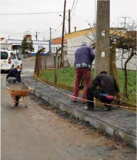
>> Obras de melhoramento urbanístico com a execução de novos passeios na localidade de Olhas
