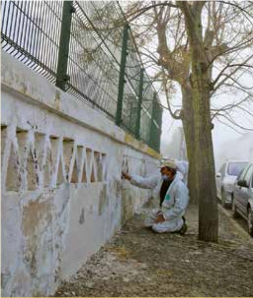
>> Trabalhos de reparação e pintura do muro da Escola do Ensino Básico de Ferreira do Alentejo
