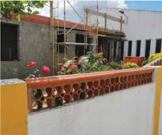
>> Obras de ampliação do edifício da Junta de Freguesia Alfândão e Peroguarda
