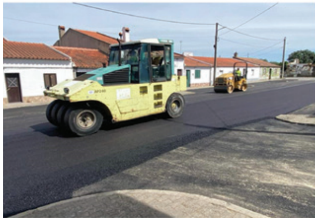
A Câmara Municipal concluiu o trabalho de nova pavimentação da Rua dos Celeiros, em Canhestros.
