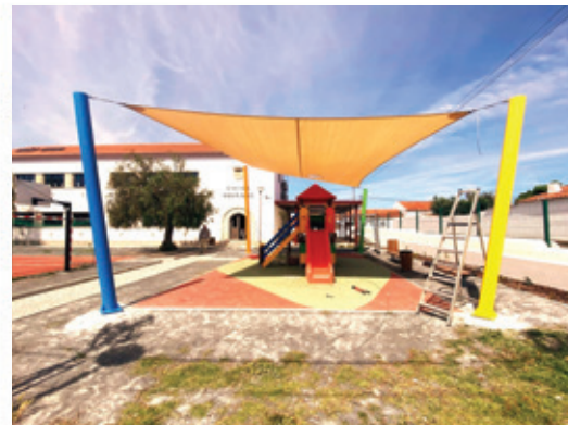
Trabalhos de colocação de ensombramento no Parque Infantil da escola de Canhestros.
