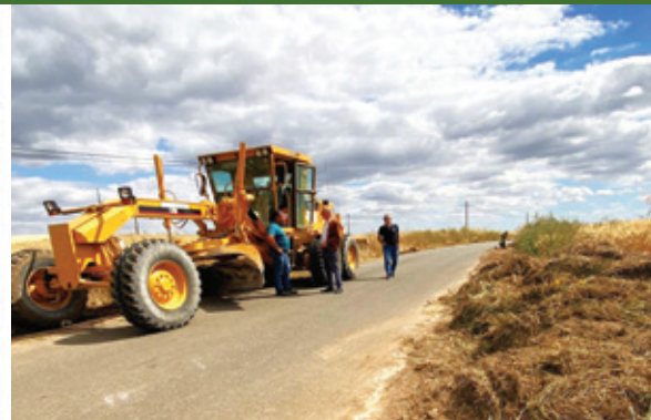
Iniciada obras de melhoramento da estrada - Aldeia de Ruins - Fortes...
