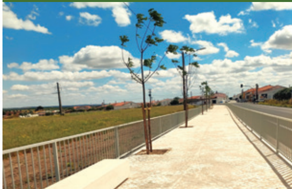
Construção de via de acesso ao cemitério em peroguarda, fora da Estrada Nacional. melhor acessibilidade e mais segurança.
