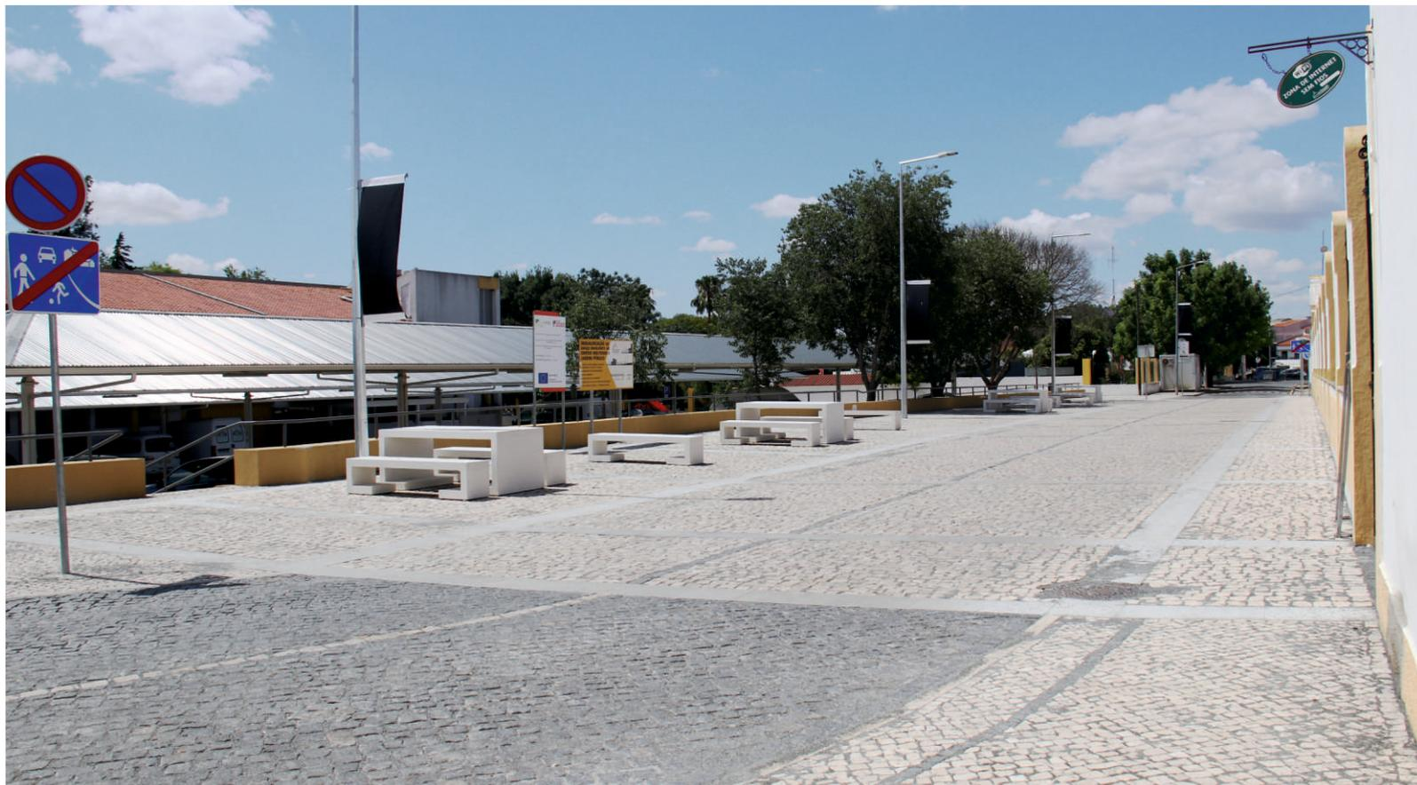
Substituição do piso para calçada, substituição das canalizações e construção de uma zona de prioridade para peões.
