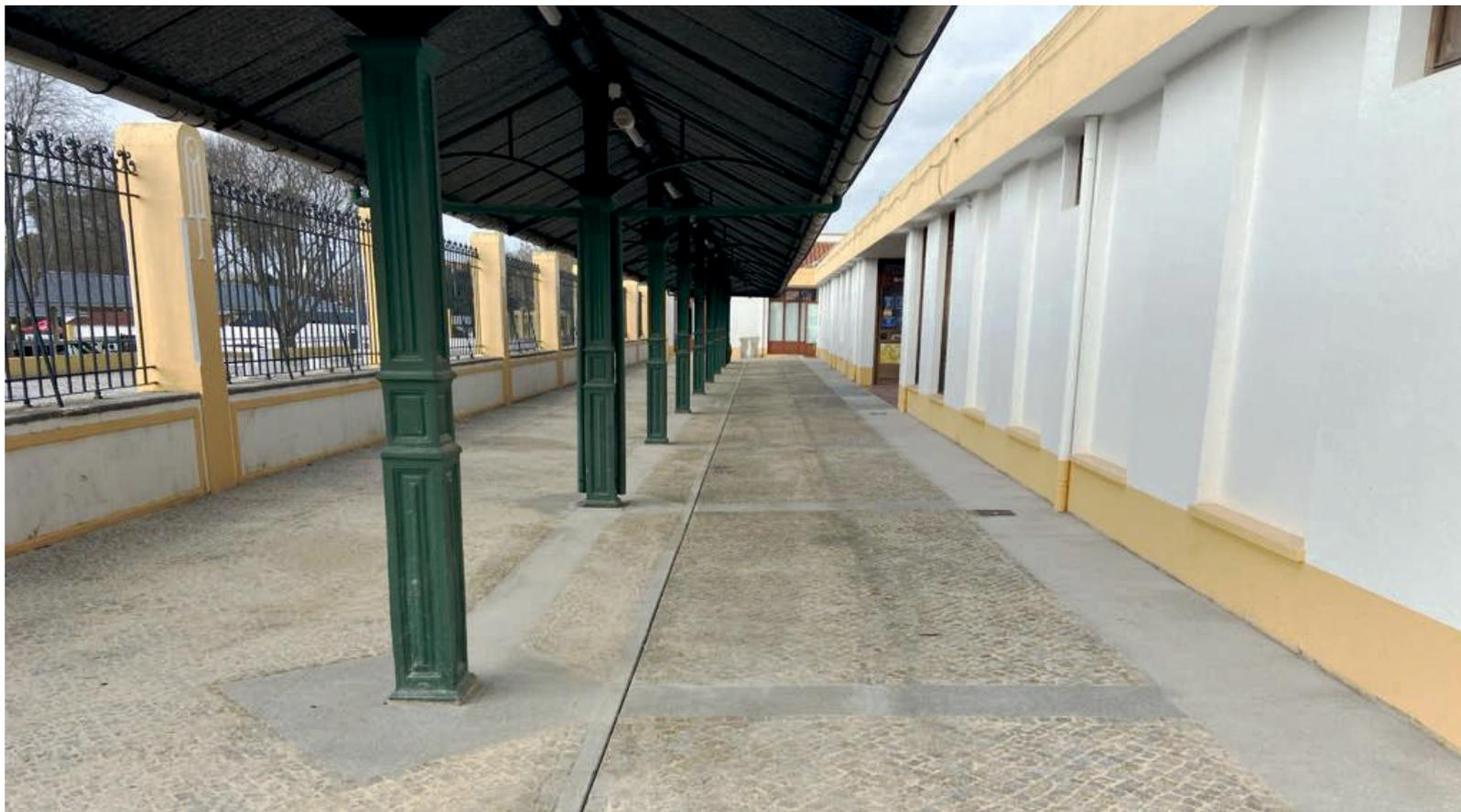
Melhoramento do espaço com a substituição do pavimento existente por calçada de granito.
