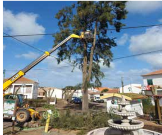
Limpeza de Árvores
